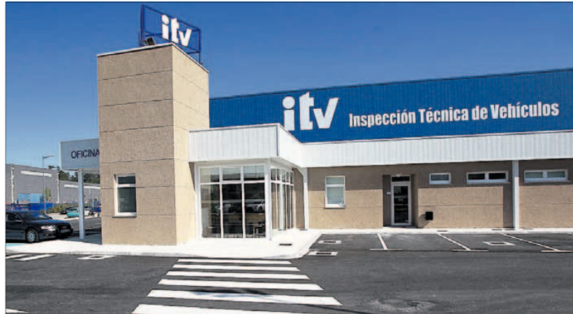
Vista exterior de una estación de Inspección Técnica de Vehículos. | JOSÉ LORES
